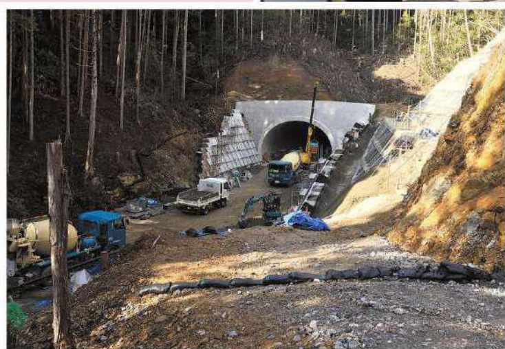
国道257号と付替県道瀬戸設楽線 接続点付近5号トンネル
